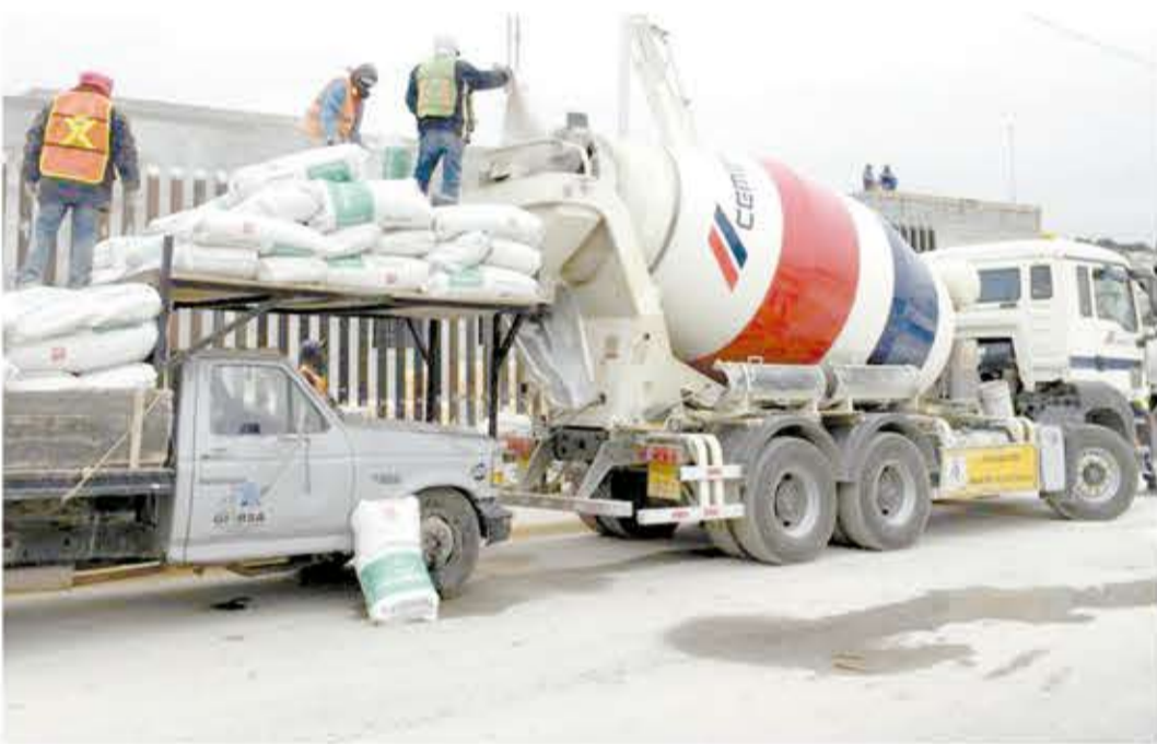
LA CLÍNICA de Mama registra un avance global del 75 por ciento en su construcción y estará lista en mayo.
